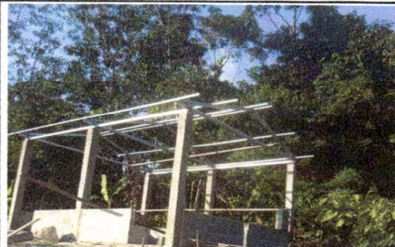
Foto 2: Sustitucion de soporte de madera por metal (Cocina)
