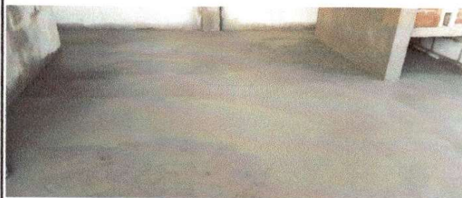
Foto 4: Sustitución de piso de tierra por piso de cemento líquido (cocina)
