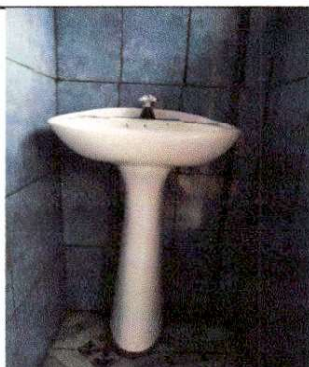
Foto 9: Sustitución de lavamanos en baño.
