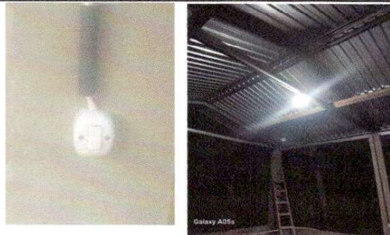
Foto 8: Reparación de sistema eléctrico en cocina y baños
