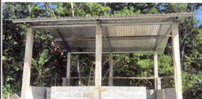
Foto1: Sustitución de lámina, por lámina troquelada aluzic calibre 26 (Cocina)
