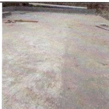
Foto 3: Sustitución de piso de tierra por piso de torta de concreto (modulo 1)
