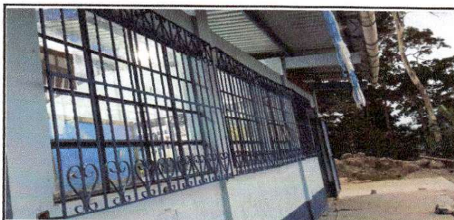
Foto 6: Fabricación e instalación de balcones de hierro metal alrededor de aula y Dirección
